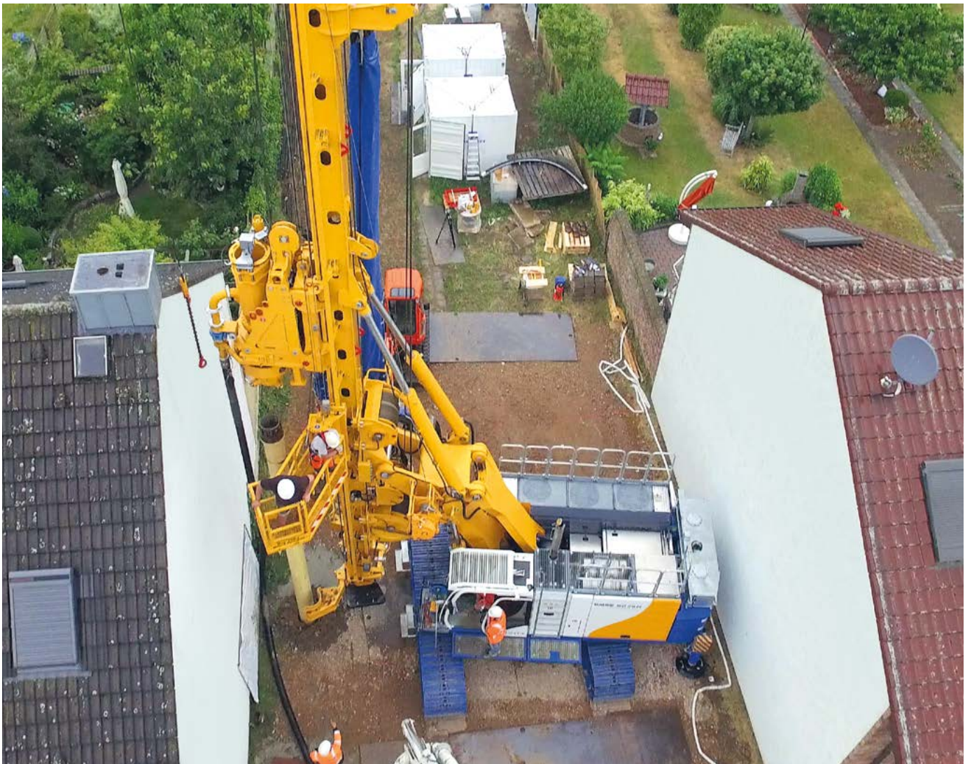
BG 36 H, FDP-Lost Bit, Gründung, Deutschland BG 36 H, Foundation Piles, Germany
