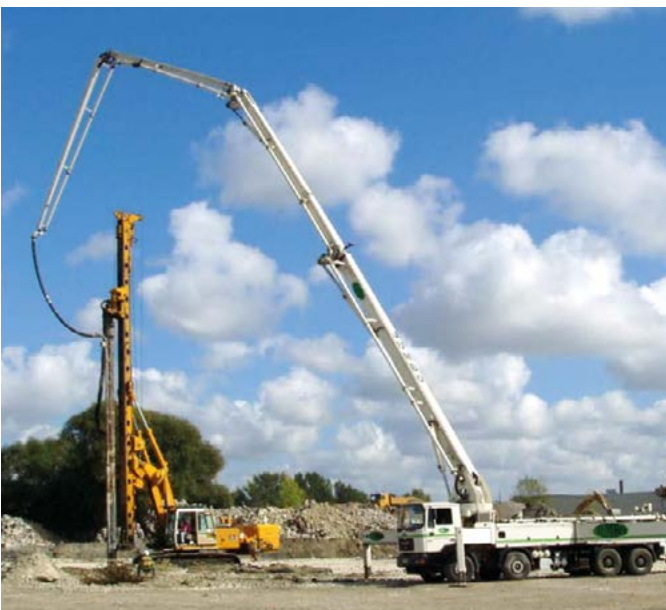
Rüttelortbetonsäulen (ROB) Vibro Concrete Columns (VCC)
