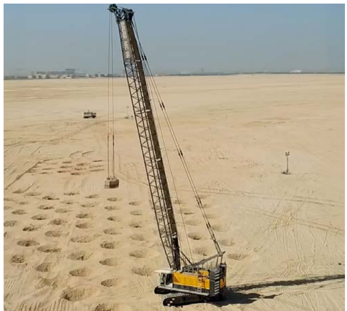
Bauer Dynamische Bodenverdichtung (BDC) Bauer Dynamic Compaction (BDC)
