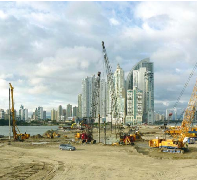
Rütteldruckverdichtung Vibro Compaction
