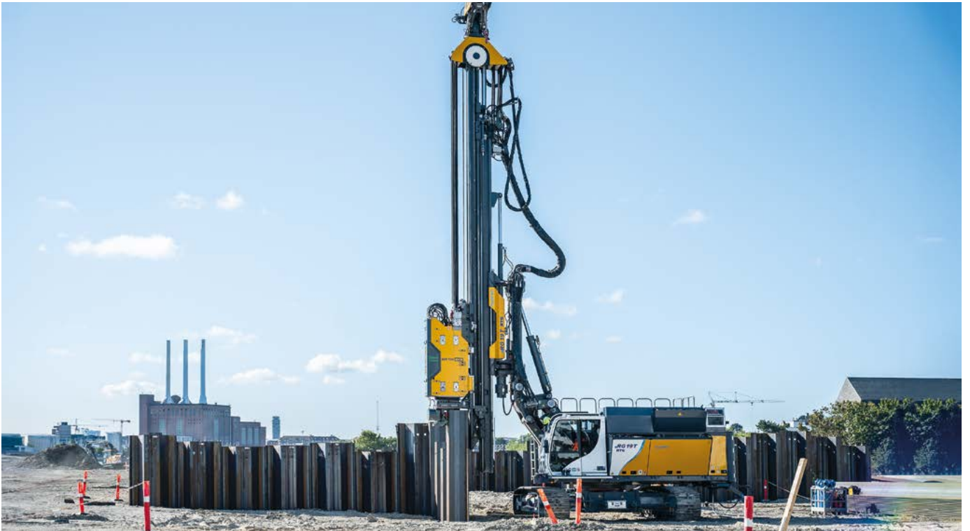
RG 19 T, Spundwand-Rütteln, Dänemark RG 19 T, Sheet Pile Driving, Denmark
